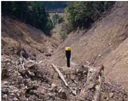
砂防工事の安全管理
