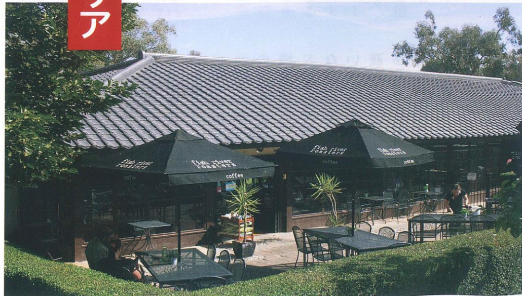
カウラ日本庭園の石州瓦（同庭園提供）
