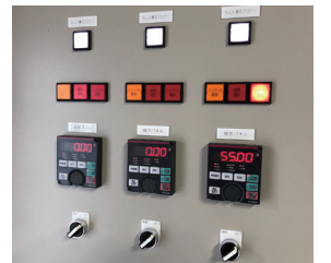
▲〔岩国工場〕ばっ気ブローアインバーター化 操作部分
