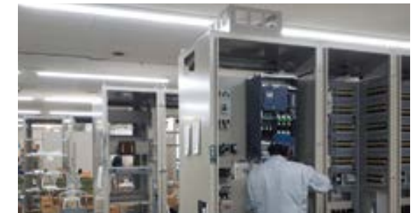
▲電機工場の照明のLED化
