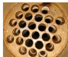
エミール設置： 熱交換器出口側にスケールの付着がみられない
