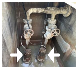
ポンプを複数台設置している様子
