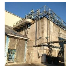
施設は全て地上に建設
