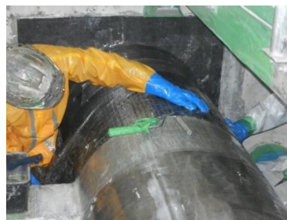
施工している様子。
