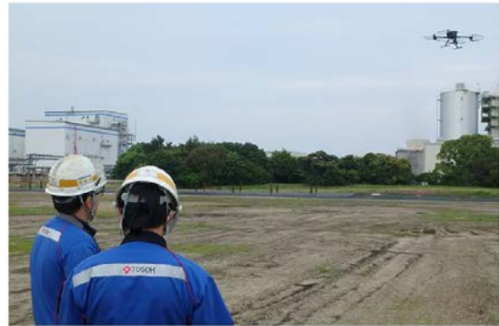
ドローンの導入による高所外観点検
