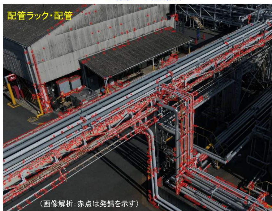
図 2-18 ドローン撮影と画像解析の検証試験結果（配管ラック・配管の例）
