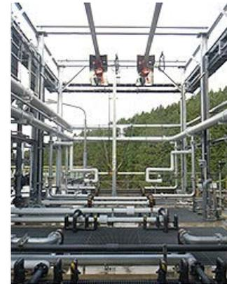
ポアフロン®膜分離排水処理装置
