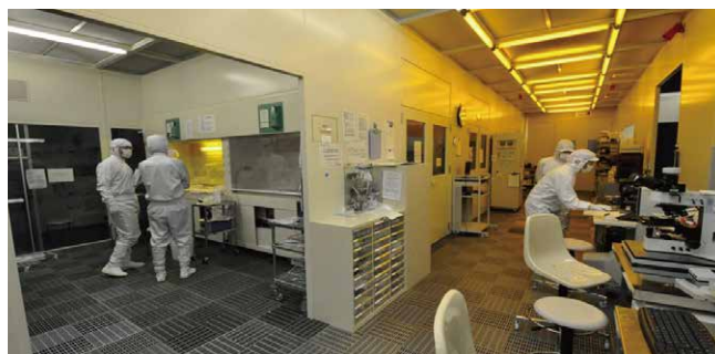
西棟520㎡(クラス100)/東棟310㎡(クラス10) クリーンルーム
