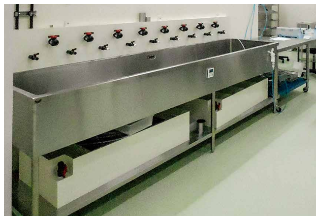
洗浄用クリーンルーム (洗浄・乾燥・梱包) クラス6(粒子上限濃度:800個/cf)
