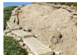
自然保護のための 遊歩道の整備
