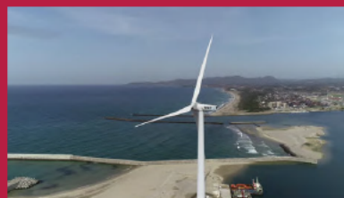
高津川風力発電所 (益田市高津町)
