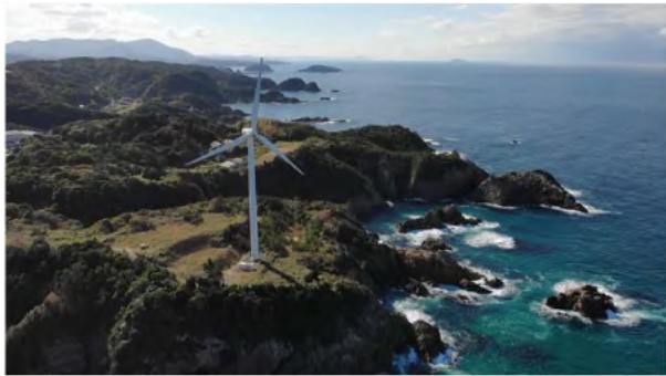
浜田市: 浜田生湯温泉風力発電所 (1, 500kW) 2004年3月運転開始
