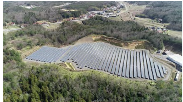
浜田市: 金城メガソーラー太陽光発電所 (1, 660kW) 2015年12月運転開始
