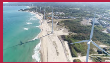
江津東ウィンドファーム風力発電所 (江津市浅利町)
