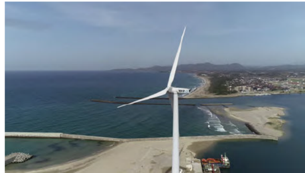
益田市: 高津川風力発電所 (1, 950kW) 2008年2月運転開始
