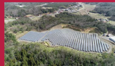
金城メガソーラー太陽光発電所 (浜田市金城町)
