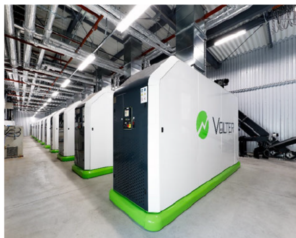
Volter40 × 12基 ガス化発電プラント ↓
