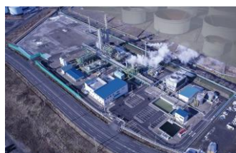
CO2分離・回収・貯留施設
