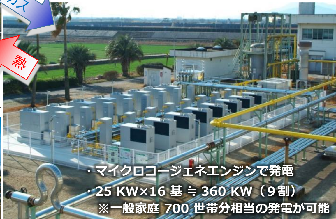
消化ガス発電設備 ▶
