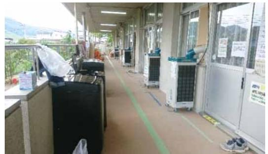
図3-V-1-2:学校に設置したスポットクーラー
