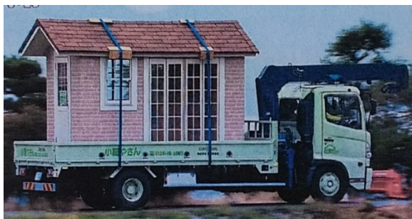
(写真3)完成した小屋を工場から現場にトラックで直送 (悪天候でも工場で作り上げ、トラックで設置 場所に運ぶ。) [株)植田板金店の提供]
