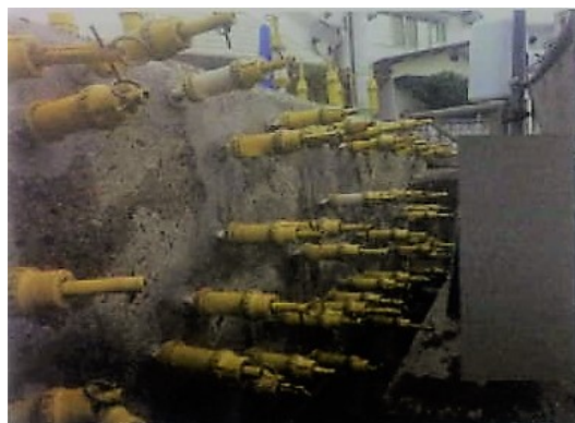
(写真5)側壁の亀裂に薬液を圧入作業中の状況 (注入が終了後、塗装する) [福徳技研(株)提供]
