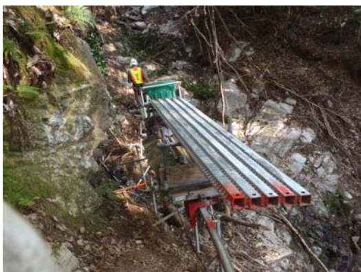
(写真3) 広島市安佐南区土砂災害現場に 土木工事用の資材をモノレールで 運んでいる例
