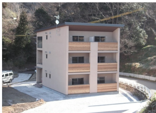
(写真3) 国内初のCLTによる3階建ての建築物
