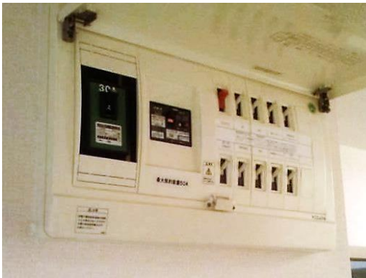
（写真1）個人住宅にセットで取り付けられている一群の開閉器（右）とブレーカー（左端）の例
