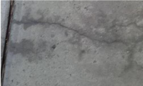
(写真1) 大きなひび割れが見られた通路の床
