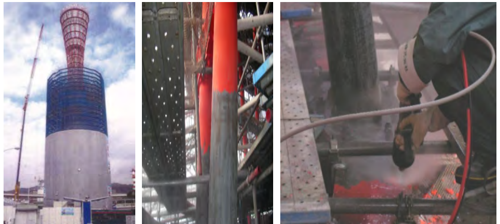
神戸ポートタワーでの試験施工例
